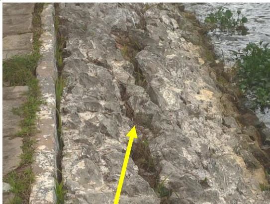
O enrocamento de proteção à montante do dique do Açude, está completamente danificado.
