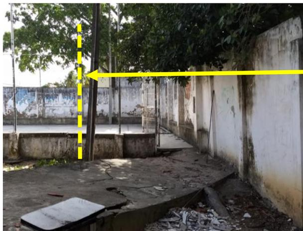
Provável movimento do solo em 'cunha' já evidenciado pela rotação de elementos visíveis (veja o poste já está cerca de 30º graus inclinado em relação ao eixo vertical )
