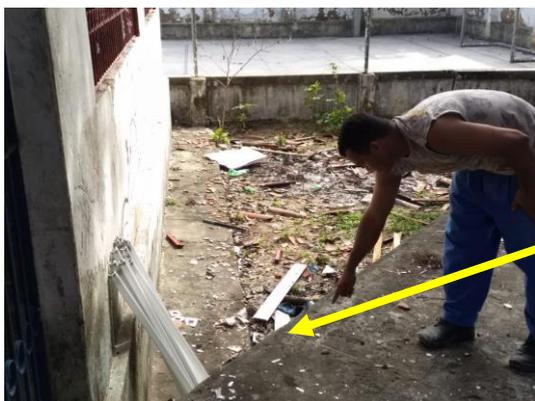
fissuras típicas de 'rompimento em cunha' já se delimita seu plano de ruptura no piso da quadra contígua ao muro colapsado e avança em direção ao prédio da Escola EMF Flávio Ribeiro Coutinho.
